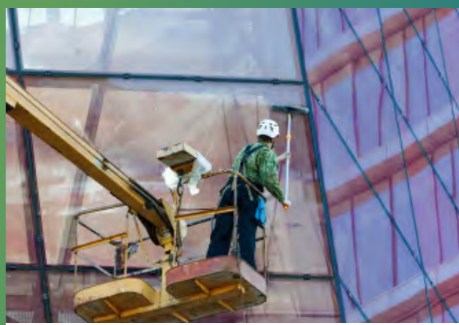
Prace czystościowe na wysokościach z wykorzystaniem technologii mycia pod ciśnieniem
